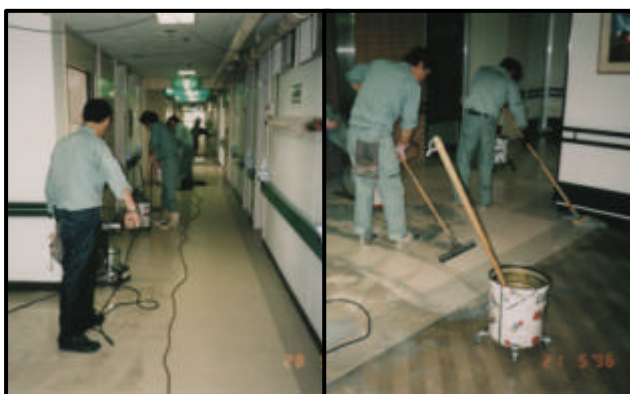
剥離・ワックス塗布作業
